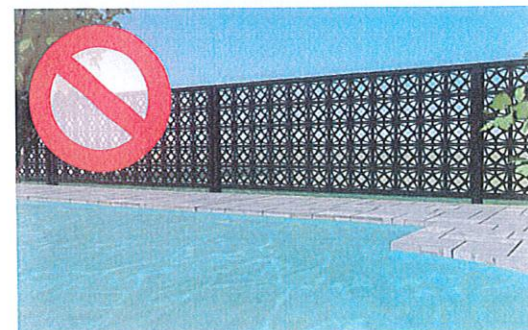
Exemple de clôture ornementale qui peut être escaladée facilement.
